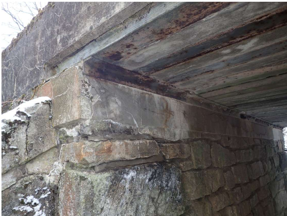
Foto 5: Degradace betonu, popraskané spárování, koroze ocelových prvků
