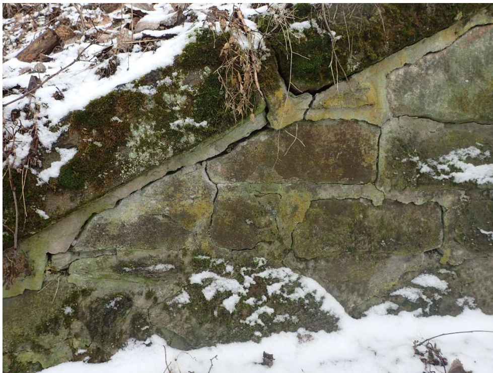
Foto 3: Spárování na křídlech popraskané, místy vypadané
