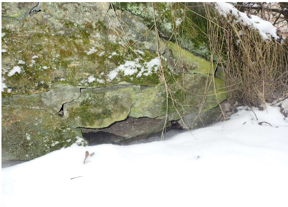
Foto 4: Místy vypadlé kameny a spárování v křídlech
